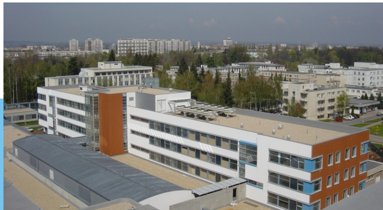
Fakultní nemocnice Hradec Králové - interna - rok 2003, objem zakázky 6,6 mil. Kč dodávka a montáž tepelné izolace a hydroizolace ploché střešní včetně klempířských prvků
