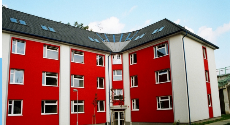
Bytový dům v Tovární ulici v Kolíně - rok 2006, objem zakázky 1,2 mil. Kč dodávka a montáž střešního pláště včetně krovů, klempířských prvků a střešních oken Velux
